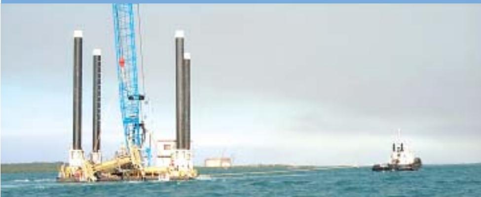
LNG Jetty Construction Equipment
